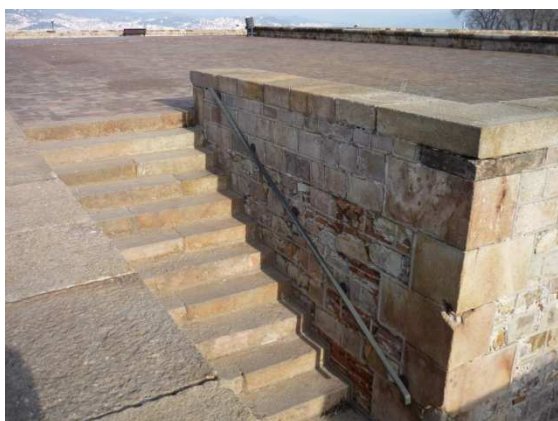
Fig. 27. Vista de les escales d'accés a la coberta
