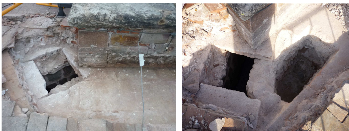
Fig. 33. Detall de l'enllosat original de la coberta del pati d'armes i rebliment de pedres per sota d'aquest.
