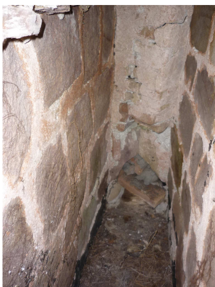
Fig. 31c. Canalització i gàrgola
