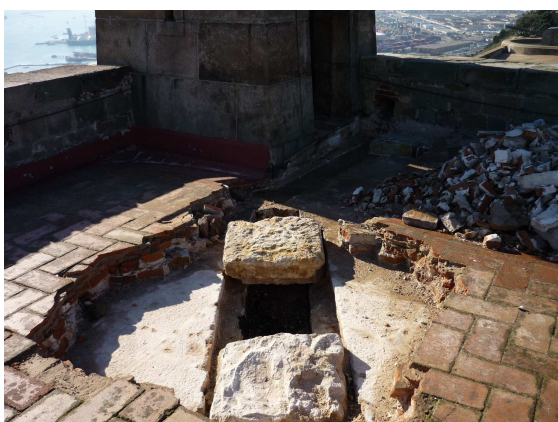
Fig. 30. Vista detallada del canal que reconduïx l'aigua cap al pati d'armes i gàrgola.
