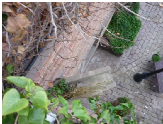
Fig. 30. Vista detallada del canal que reconduïx l'aigua cap al pati d'armes i gàrgola.
