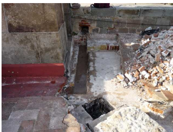
Fig. 34. Vista del sondeig 12
