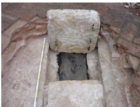
Fig. 35. Detall de la canalització UE 1211
