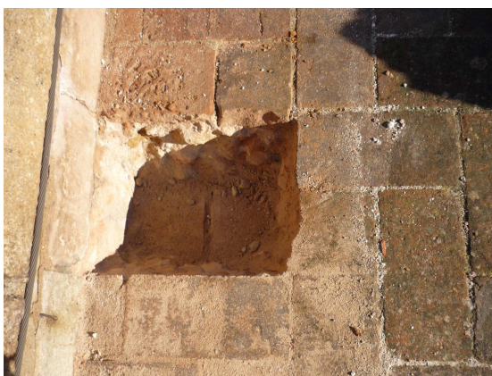
Fig. 26. Vista detallada de la successió de paviments en diferents llocs de la coberta.
