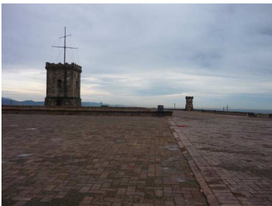
Fig. 22. Vista general de la coberta a la cantonada sud-est
