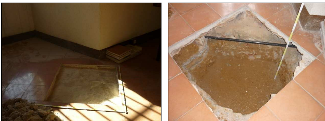
Fig.8: Detall del sondeig 5 realitzat a la sala 2 de l'antic Museu.
