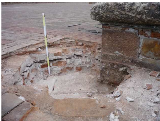
Fig. 26. Vista detallada de la successió de paviments en diferents llocs de la coberta.
