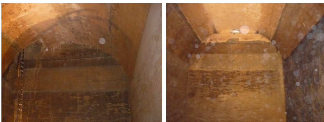
Fig.19 Vista de l'interior de la cisterna.
