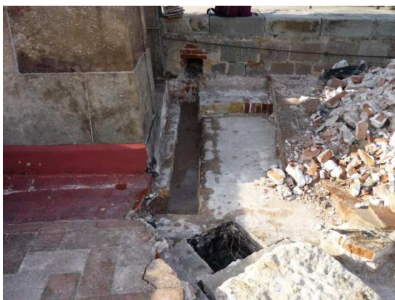
Fig. 29. Vista detallada del canal paral·lel al mur perimetral exterior als sondeigs 13 i 12
